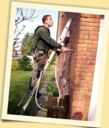
**DUROLAN®** Kerndämmung fürs Mauerwerk
